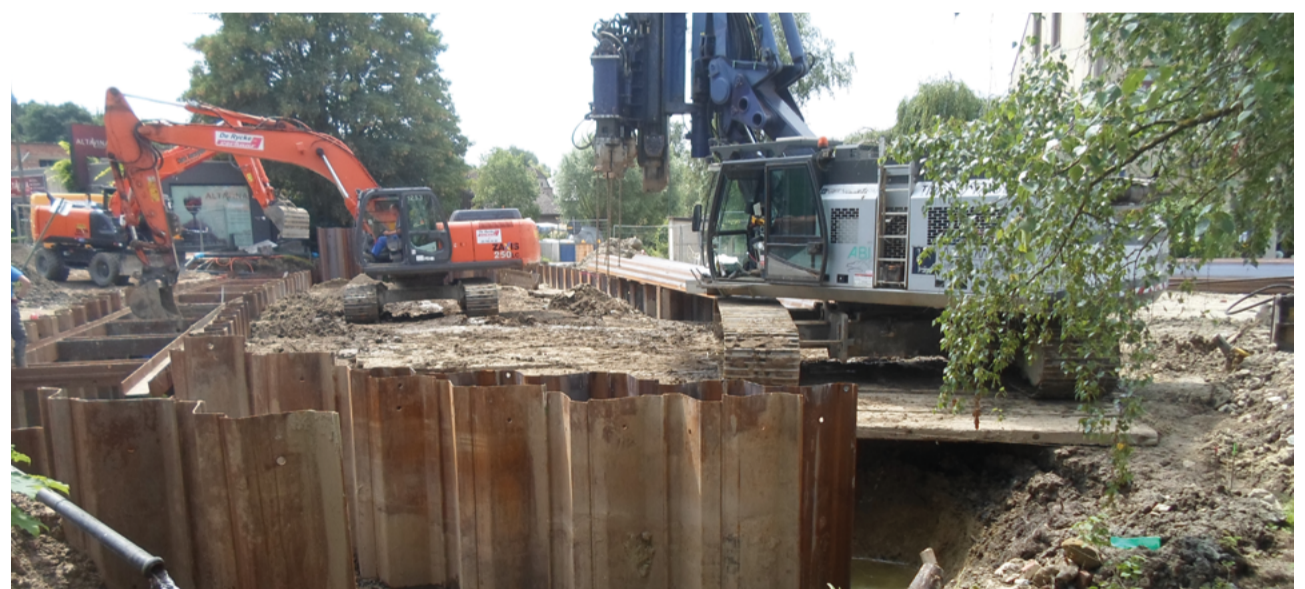
Een beek verplaatsen, vraagt veel voorbereiding.
