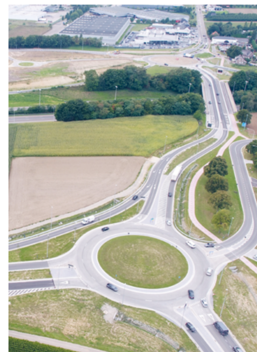
Vernieuwd op- en afrittencomplex E313 in Tongeren.
