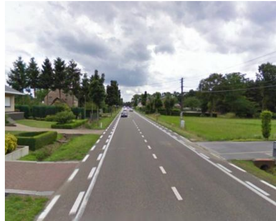
Foto 2: lintbebouwing N165 met
