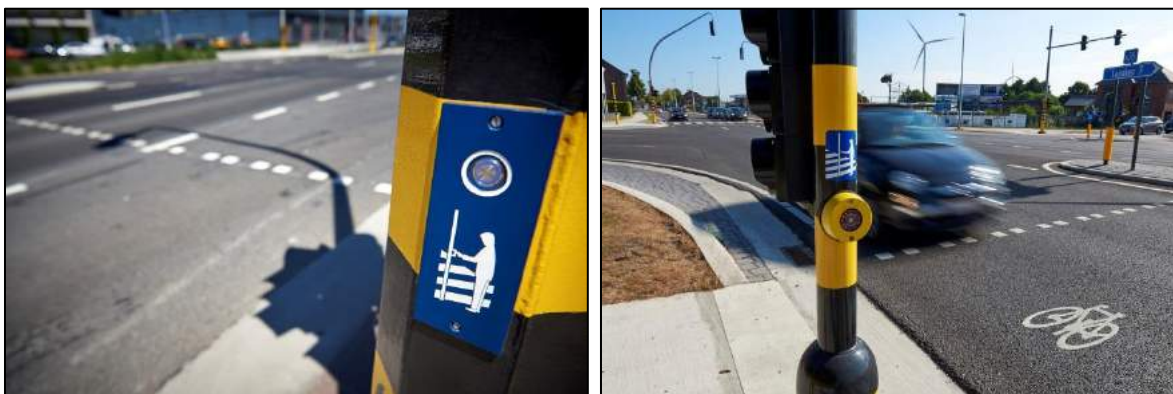
Figuur 97 Voorbeelden van drukknoppen voor voetgangers
