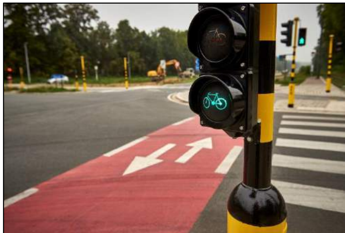
Figuur 61 Bij deelconflicten is het aangewezen om fietsers- en voetgangerslichten gelijktijdig groen en rood te laten worden
