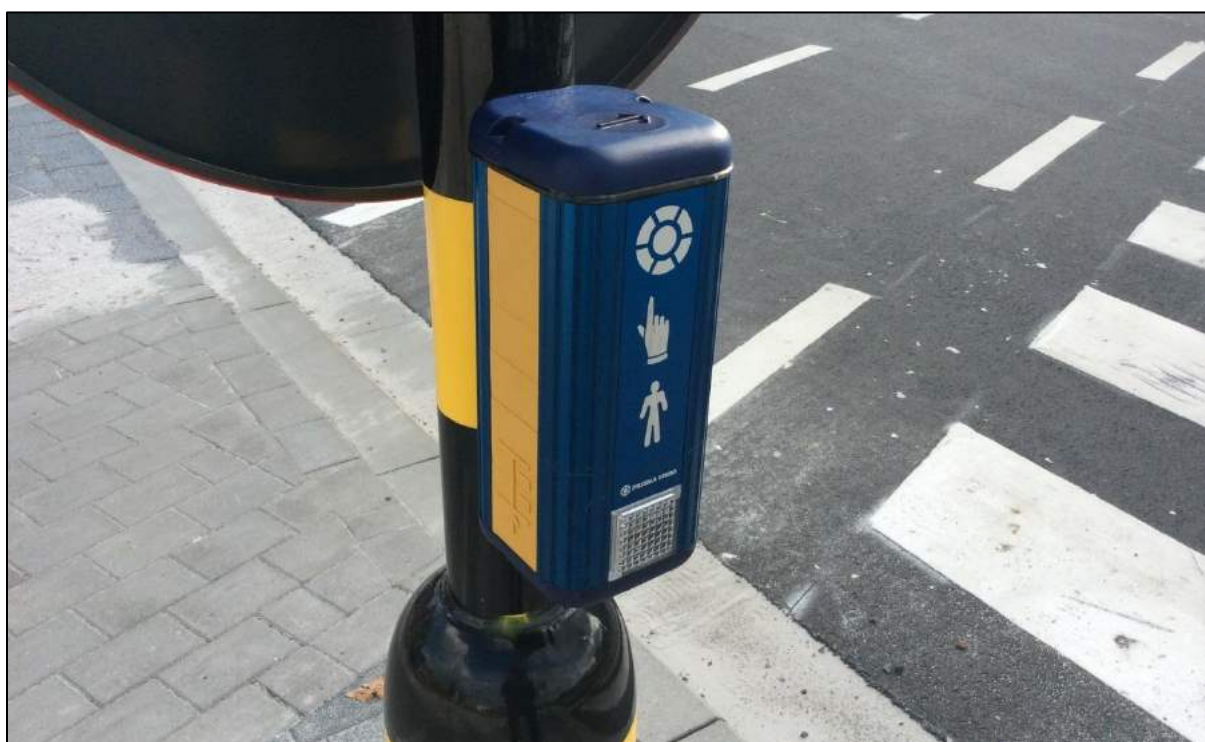
Figuur 98 Druknop voor voetgangers met een visuele beperking
