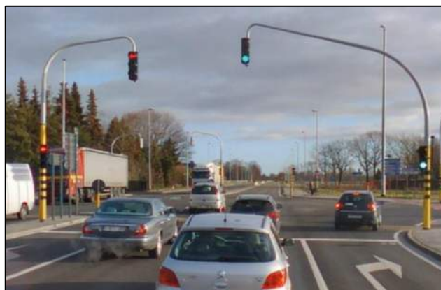
Figuur 26 Volle lens in combinatie met een driekleurige pijllicht linksaf
