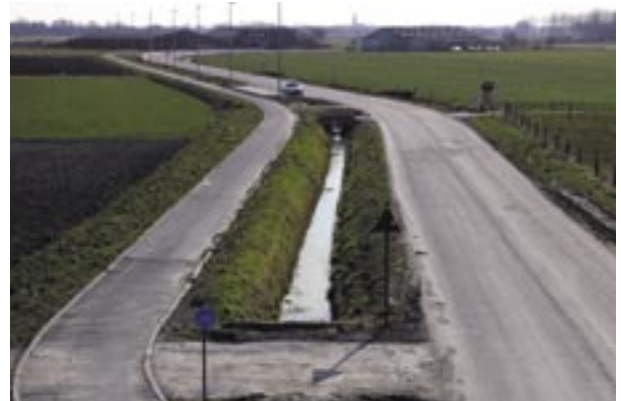
➤ Met het oog op de afwatering van de weg is de gracht behouden tussen de weg en het fietspad.
