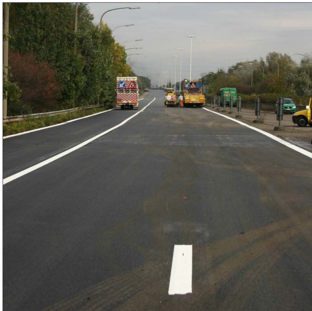
Aanbrengen van de nieuwe markeringen
