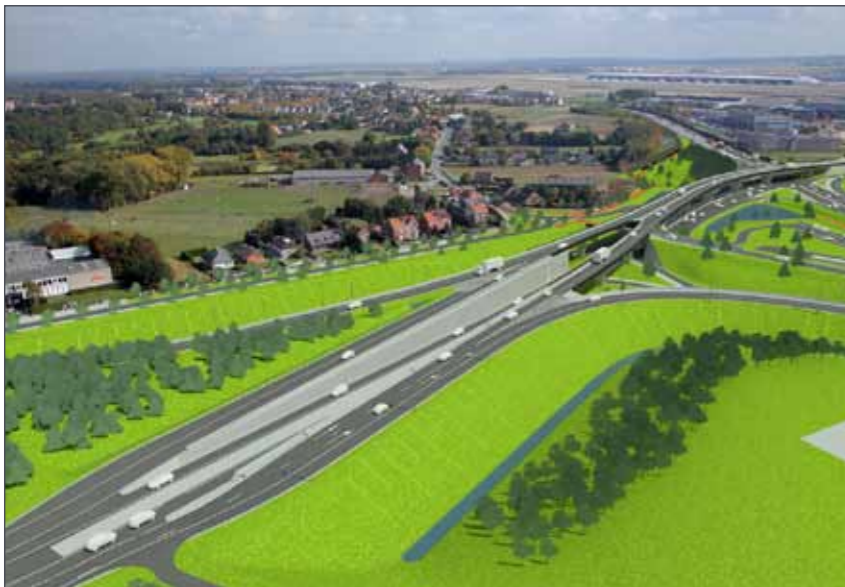
Het verkeer vanuit Antwerpen krijgt een nieuwe afrit, het verkeer in de richting van Antwerpen een nieuwe oprit. Het viaduct loodst het vrachtverkeer Brucargo binnen.
