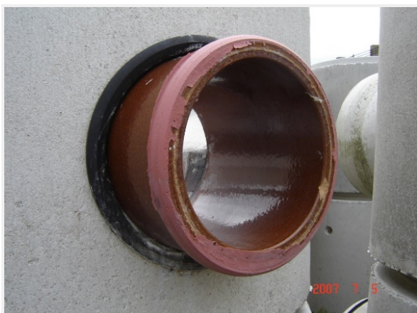
Figuur 2-2-10: voorbeeld inlaatmof in gres aangebracht met rubberen dichtingsring in aansluitopening 2.6.2.6.B.3 Type 2.3 met rubberen manchet in schuin geboorde aansluitopening
