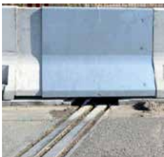
figuur 29: Dilatatie-element bij betonnen afschermdende constructie
