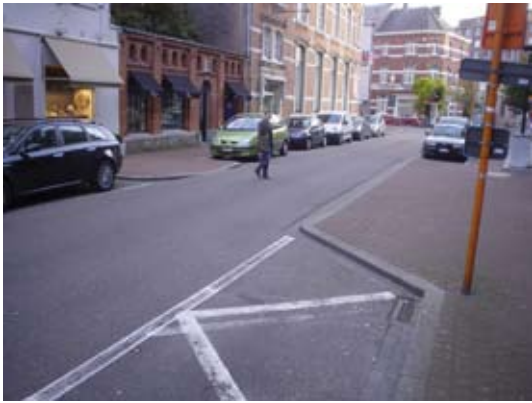
Fig. 2.2.2b Een trottoiruitstulping vergroot de zichtbaarheid van de voetganger en de oversteek wordt verkort.
