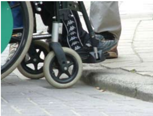
Fig. 2.1.4a Niveaunderschillen > 2cm zijn voor het merendeel van de rolstoelgebruikers niet zelfstandig overbrugbaar.
