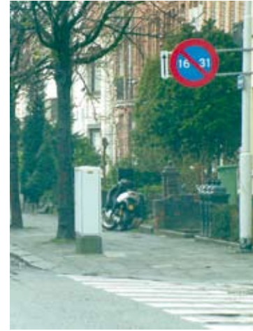
Fig. 2.1.1j Door de verkeersborden 1 aan de verlichtingspaal te bevestigen is een extra obstakel in de loopzone uitgespaard. De bevestigingswijze garandeert een goede zichtbaarheid voor het verkeer op de rijbaan.
