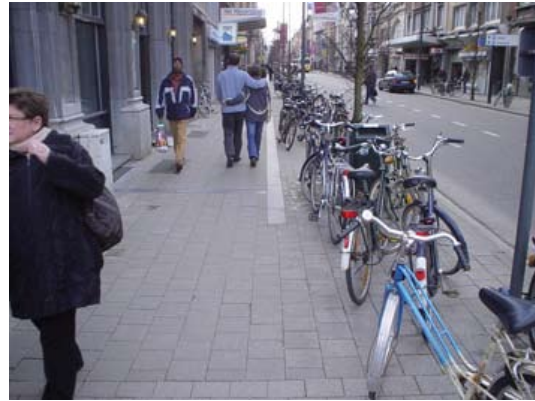
Fig. 2.1.1g Door een duidelijke vormgeving van looproute en obstakelzone wordt het wenselijk gebruik vlot opgepikt door de gebruiker van de openbare ruimte.
