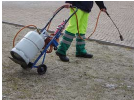
Fig. 3.1g Chemische bestrijdingsmiddelen worden in veel gemeenten niet meer gebruikt en een verbod op het gebruik komt eraan. Alternatieven zoals het branden zijn zeer arbeidsintensief. Het is verstandig om hier bij de materiaalkeuze reeds rekening mee te houden.
