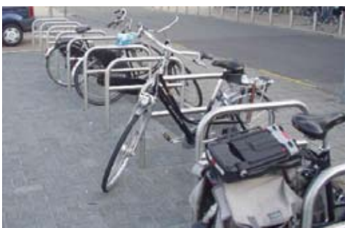
Fig. 2.1.1u De fietsenstalling is buiten de looproute geplaatst. De vormgeving van de fietsenrekken laat het gebruik voor een grote diversiteit aan fietsen toe.
