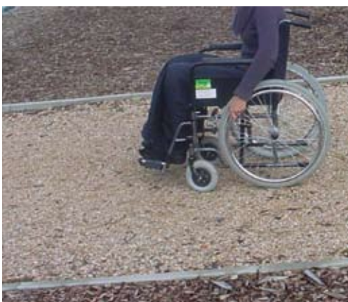
Fig.2.1.5.d Een wandelpad met een semi-verharding
