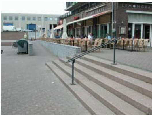
Fig. 2.1.4a4 Hier is een leuning in het midden van de brede trap geplaatst. Dit is een minder goede oplossing. Blinden en slechtzienden komen via de natuurlijke gidslijn altijd aan de zijkant van de trap uit en daar is geen leuning. Merk op dat ook waarschuwingsmarkeringen en contrastmarkeringen ontbreken.
