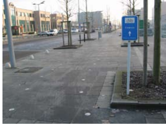
Fig. 2.1.3c Een afbakening van een fietsstrook met metalen noppen zoals hier werkt zeer verwarrend en is onvoldoende.
