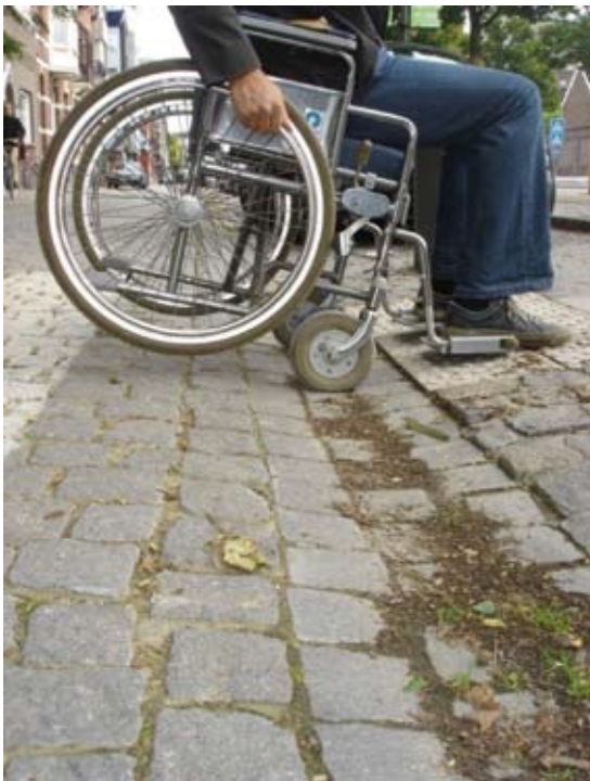
Fig. 2.1.4h Wanneer rolstoelgebruikers diepe en/of komvormige goten moeten dwarsen is het risico groot dat men met de voetsteun in aanraking komt met de grond, waardoor men kan kantelen
