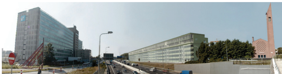
Aanzicht gevel voor en na
