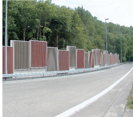
Geluidsscherm langs E40, Brugge, ontwerp THV Arcadis - A-Tech
