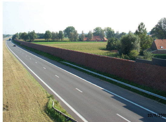
realisatie ontwerp G. Derveaux, het scherm werd opgebouwd uit schanskorven gevuld met terracottascherven, als verwijzing naar typisch materiaal uit de streek
